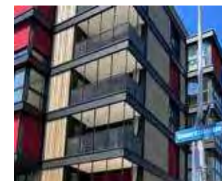
Geländer Geländer beispiel
